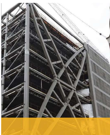
ساخت اسکلت فلزی
